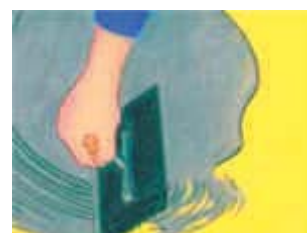
Rivestimento del pavimento con Körapur 689
