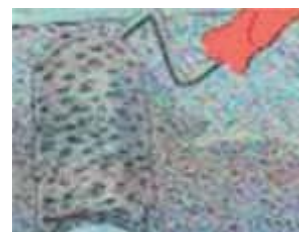
Sigillatura del granulato con Körapox BS 85
